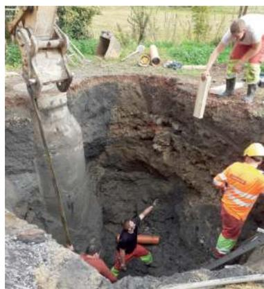
Un effondrement d'une partie du trottoir entre la benne à verre et le pont de l'écaillon est apparu après une semaine de fortes pluies. Après les investigations de Noréade, il s'est avéré que cet effondrement était dû à une fuite apparue sur le réseau d'assainissement. L'entreprise LORBAN a effectué les travaux durant trois jours. Un grand trou a été nécessaire pour la réparation d'un plus petit.
